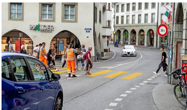
Dieser Fussgängerstreifen verschwindet. Neu wird ein Trottoir ausserhalb der Lauben (rechts) durchführen.
