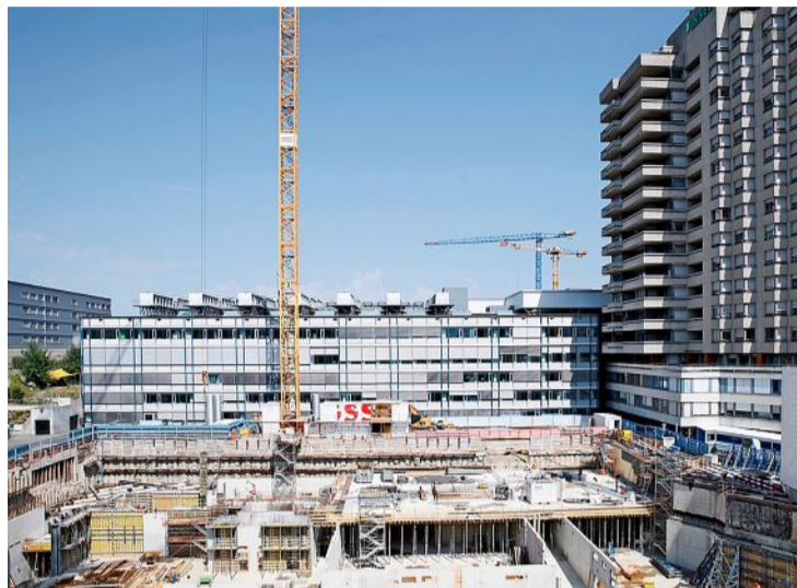
Auf dem Insel-Areal entsteht ein neues Bettenhochhaus. Foto: chp
