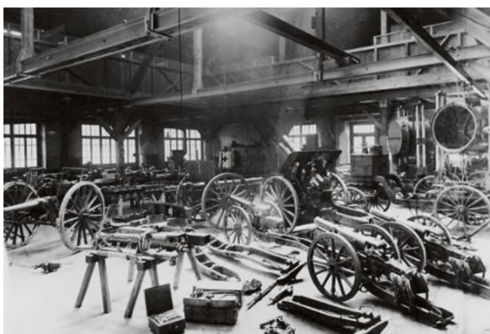
Geschützmontage in der KW Thun.
