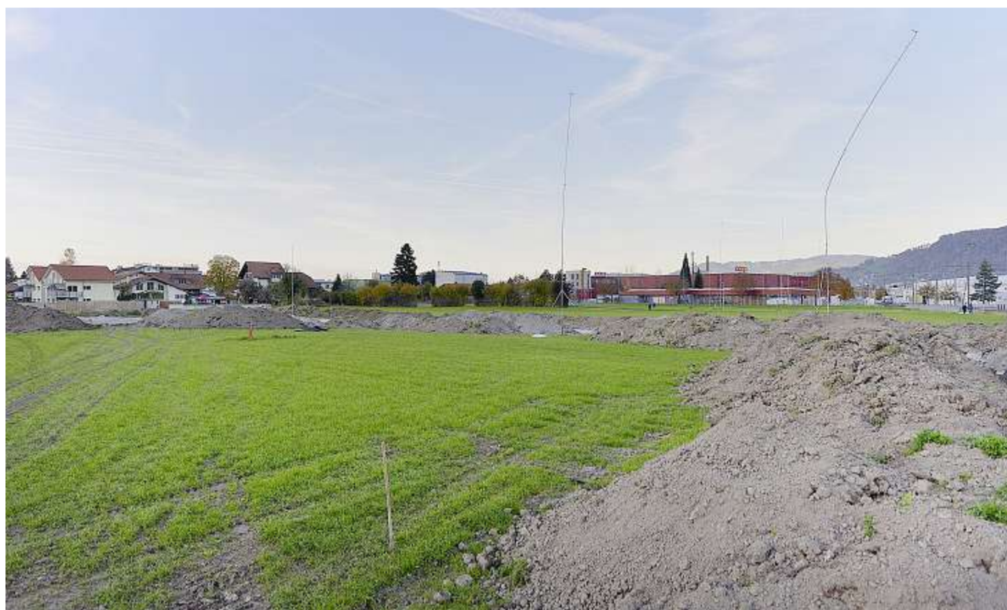
Hier im Wirtschaftspark Schoren entstehen die neue Zufahrtsstrasse und der Hauptsitz der Sozialfirma Transfair (Profile).
